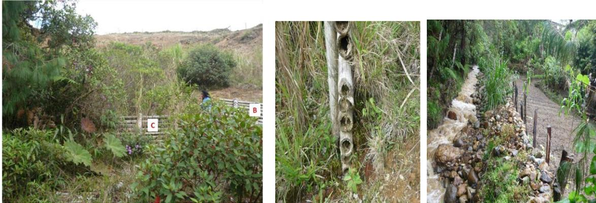
Obras de mitigación realizadas sobre las áreas de deslizamiento en la Q. La Cofradía. Frente al temor de que el material desplazado represe la corriente y se produzcan avalanchas e inundaciones de gran magnitud, se ha procurado hacer dragado en el cauce despejando material pétreo del canal y disponerlo a manera de muro de contención.
