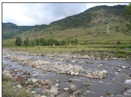
**Punto 3.** (Foto 1) Se puede apreciar las obras de mitigación que no han soportado la fuerza del río Putumayo y el material acumulado por la corriente. Sobre la parte alta de esta imagen se localiza el área de expansión propuesta por el EOT. (Foto 2) Área de afectación del río en sus máximos niveles.
